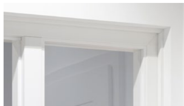
Seitenteil mit Blockzarge
